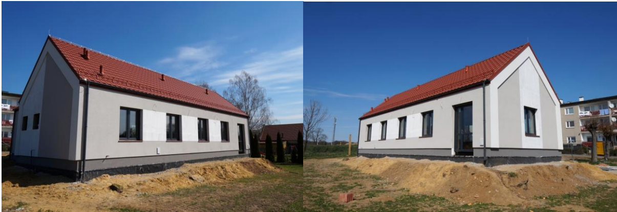
Zdjęcie 25. Widok świetlicy wiejskiej w Szczodrowicach (w budowie).
