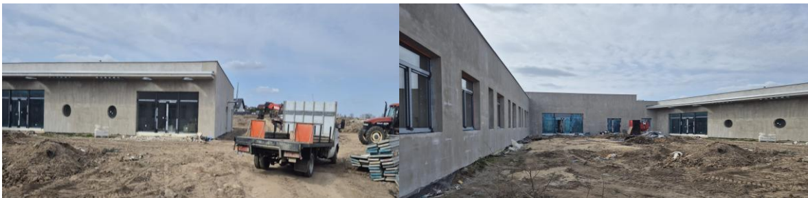
Zdjęcie 21. Przedszkole miejskie w budowie.
