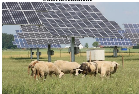
Rysunek 11. Zastosowanie rozwiązania agrofotowoltaiki w ramach farmy fotowoltaicznej Untermöckenlohe
