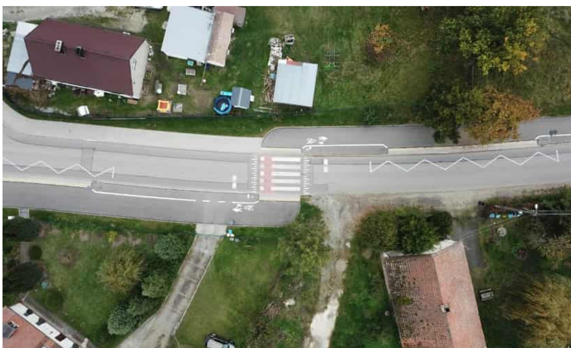
Rysunek 26. Gmina Oleśnica – przebudowa drogi powiatowej 1474 P
