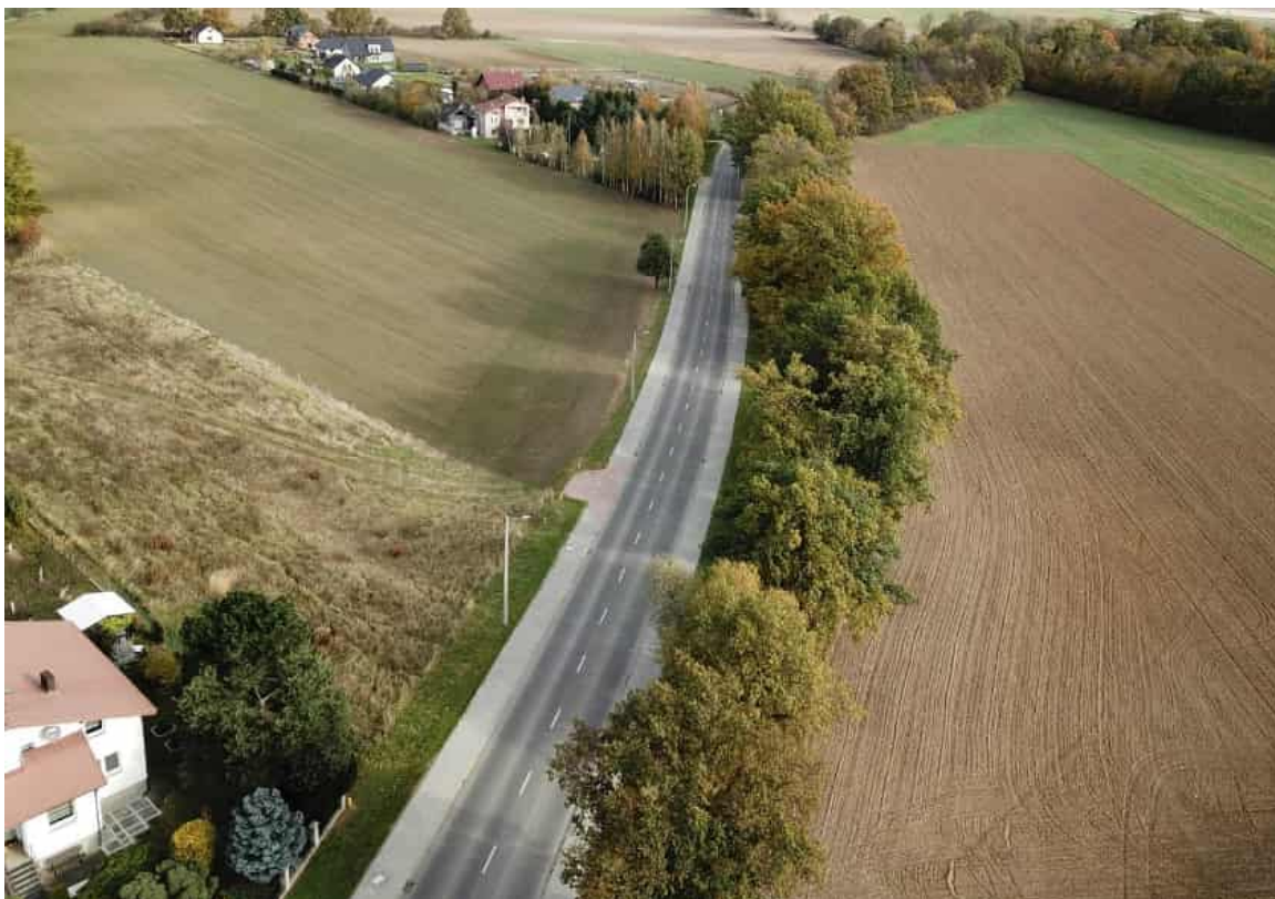
Rysunek 15. Gmina Mietków – modernizacja ul. Kąteckiej
