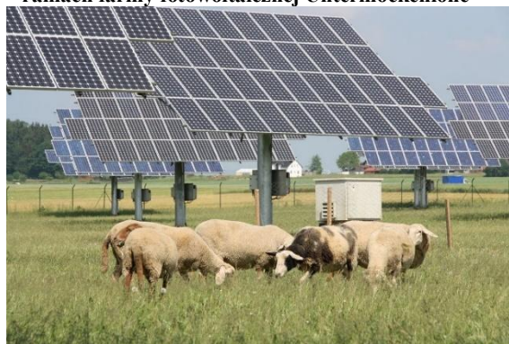
Rysunek 9 Zastosowanie rozwiązania agrofotowoltaiki w ramach farmy fotowoltaicznej Untermöckenlohe
