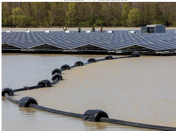
Rysunek 6 Pływająca farma fotowoltaiczna na zbiorniku Silberseen und Schmaloeer Heide w Nadrenii Północnej Westfalii w Niemczech
