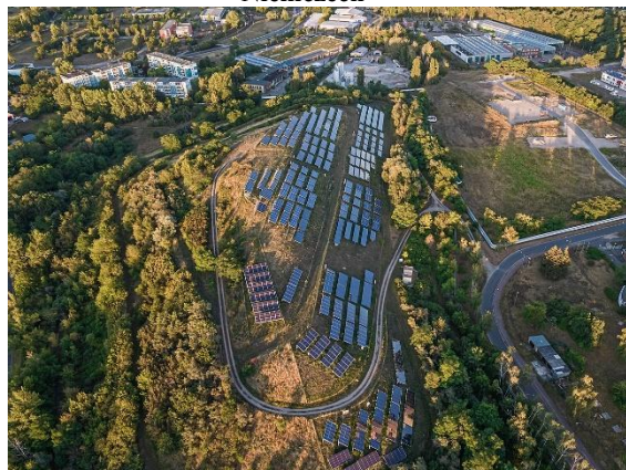
Rysunek 7 Instalacje fotowoltaiczne na dawnym składowisku odpadów we Frankfurcie nad Odrą w Niemczech
