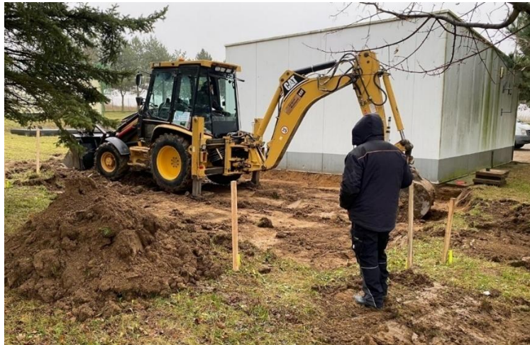
Zdjęcie 40. Prace ziemne pod wykonanie fundamentów. Rozbudowa budynku technologicznego SUW Dankowice.
