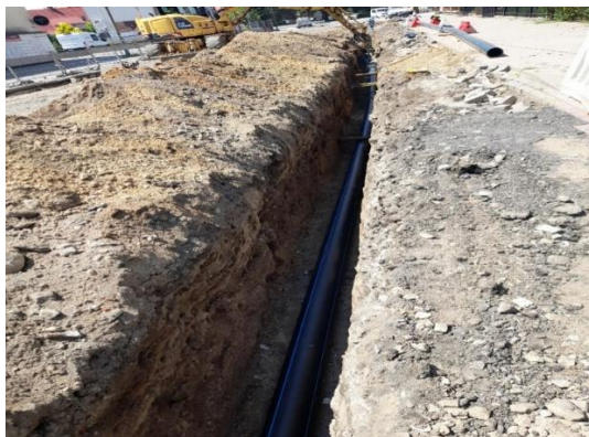
Zdjęcie 37. Budowa sieci wodociągowej w ul. Wolności w Strzelinie.
