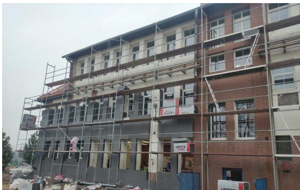
Zdjęcie 31. Budynek PSP w Kuropatniku podczas prac modernizacyjnych.
