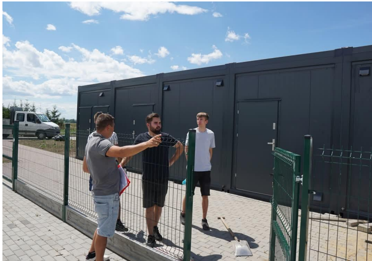
Zdjęcie 26. Szatnia kontenerowa w Pławnej.
