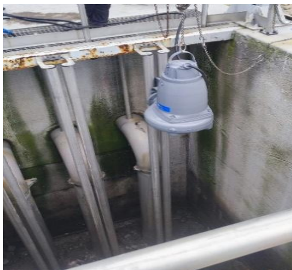
Zdjęcie 39. Montaż nowej pompy ściekowej w centralnej przepompowni ścieków w Strzelinie.
