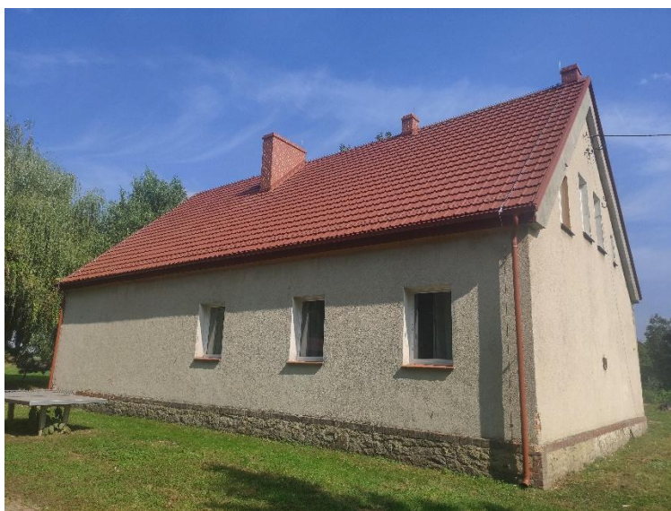
Zdjęcie 21. Nowe pokrycie dachowe na budynku świetlicy wiejskiej w Piotrowicach.
