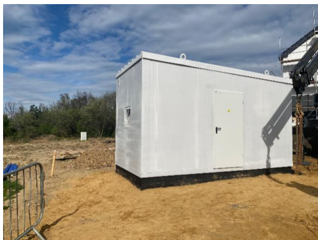
Zdjęcie 38. Montaż kontenerowej pompowni wody przy ul. Wichrowej w Strzelinie.
