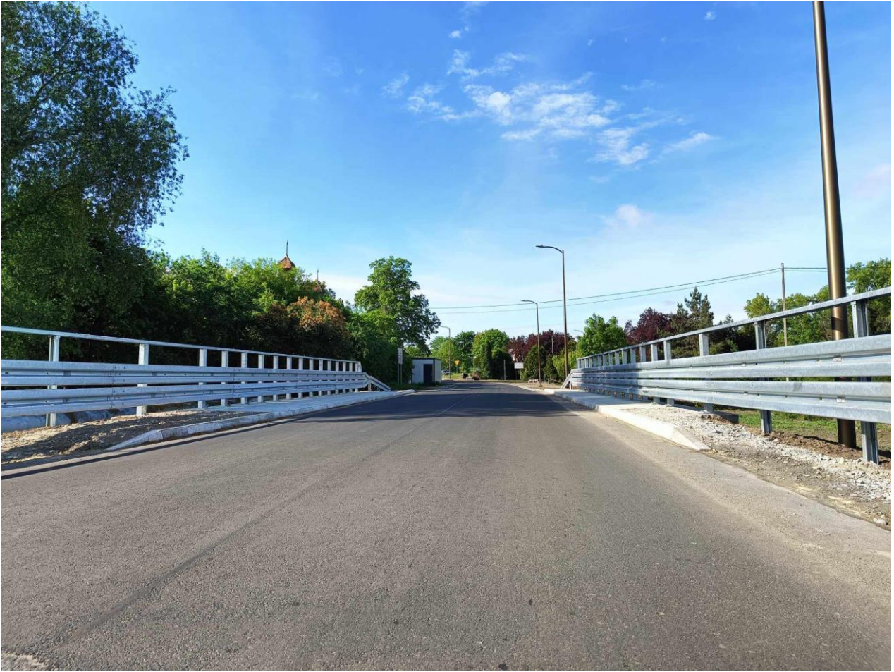
Zdjęcie 15. Nawierzchnia i bariery ochronne przebudowanego mostu na ul. Brzegowej w Strzelinie.
