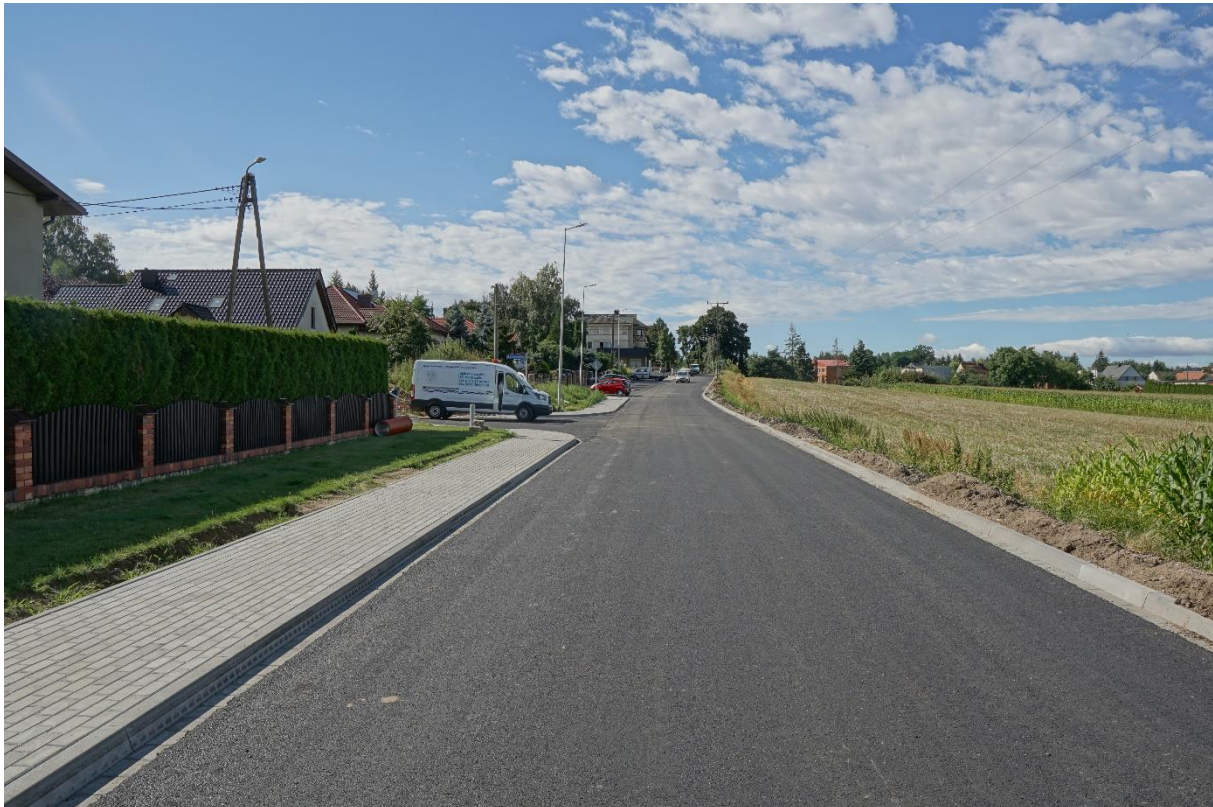
Zdjęcie 18. Widok przebudowanej ul. Pułaskiego w Strzelinie (osiedla Na Skarpie).
