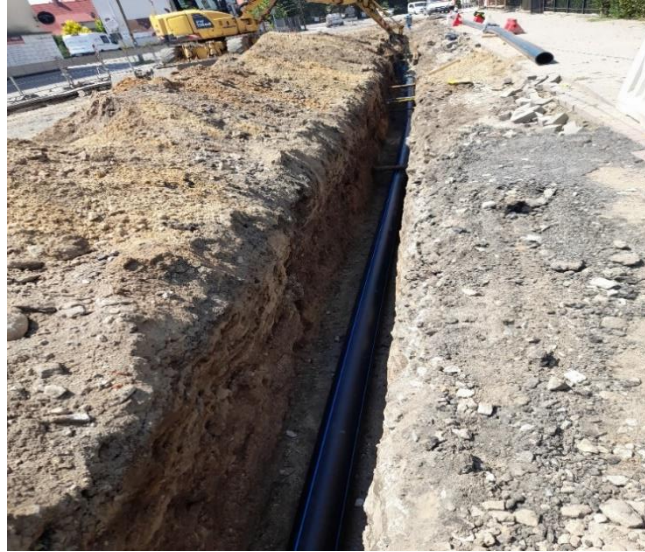
Zdjęcie 44. Budowa sieci wodociągowej wraz z pompownią wody w ul. Wichrowej w Strzelinie.
