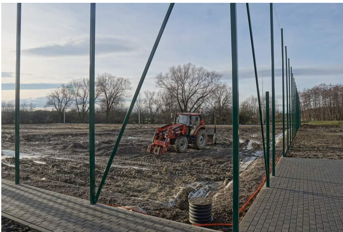
Zdjęcie 34. Budowa boiska piłkarskiego pełnowymiarowego - teren obok basenu miejskiego w Strzelinie.
