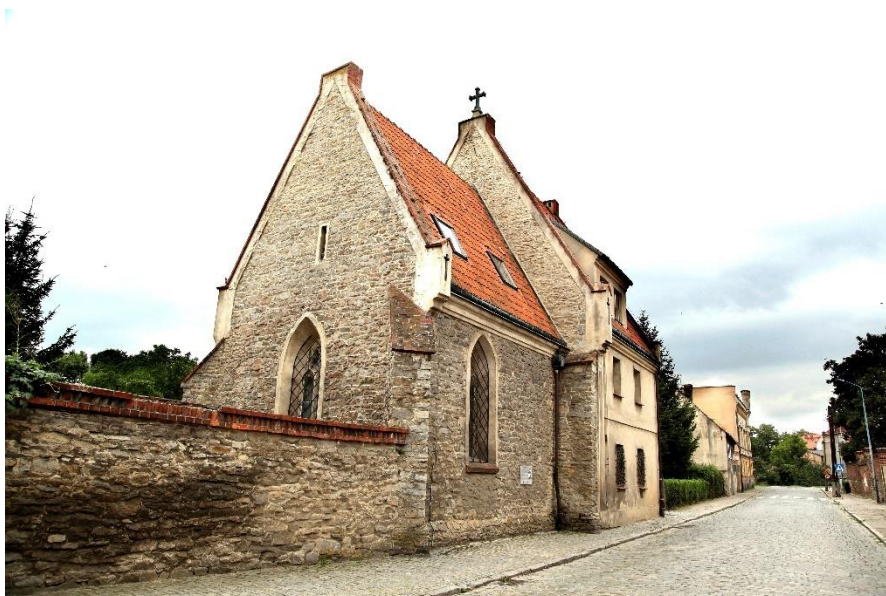
Zdjęcie 30. Zabytkowy budynek przy ul. Brzegowej przed przebudową.
