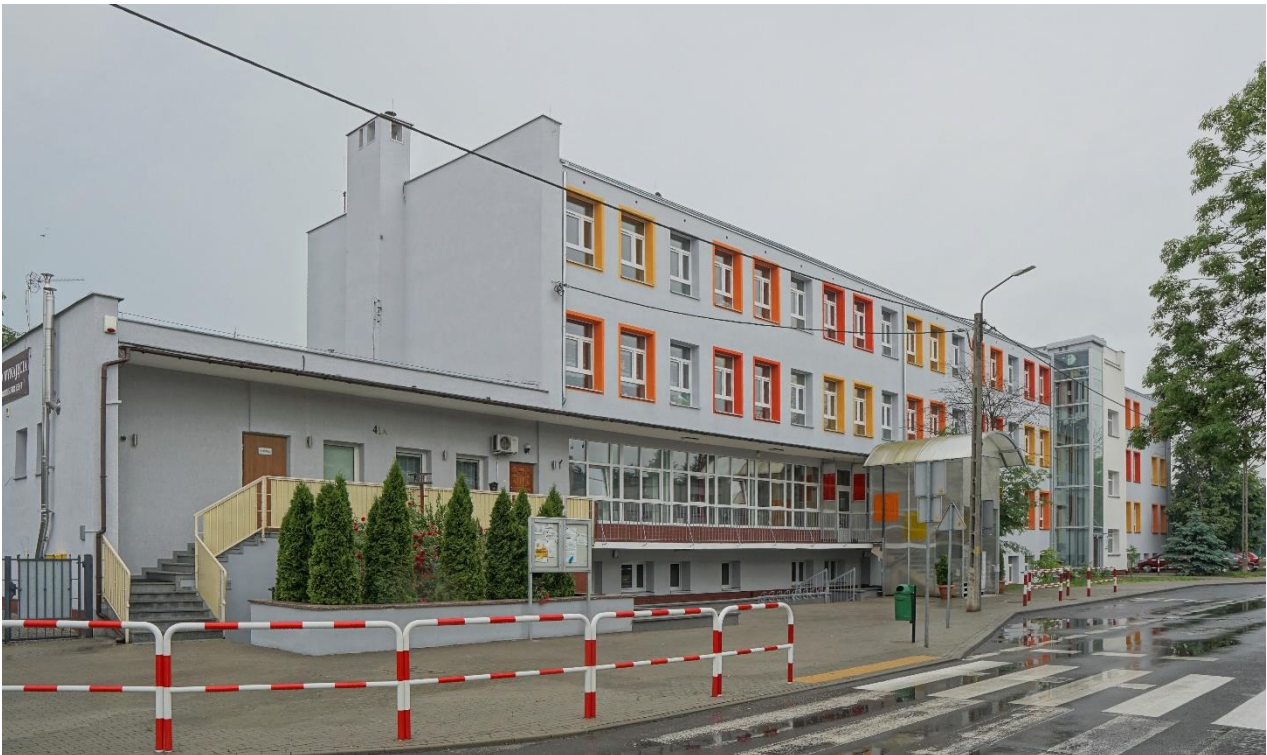
Zdjęcie 22. Budynek PSP Nr 4 im. Tadeusza Kościuszki w Strzelinie po termomodernizacji.
