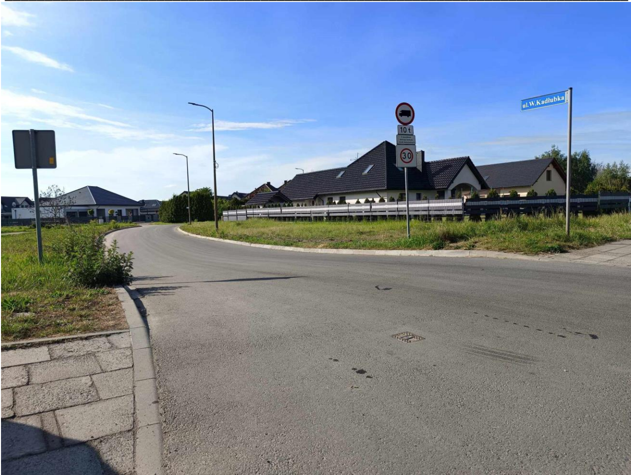
Zdjęcie 14. Nawierzchnia ul. Kadłubka w Strzelinie po przebudowie.
