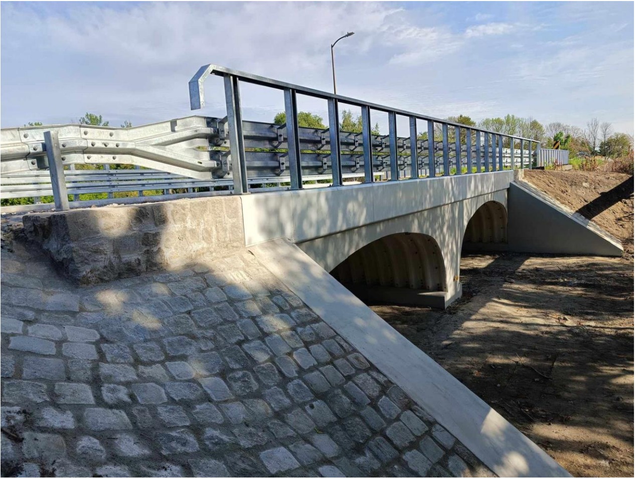
Zdjęcie 16. Przebudowywany most na ul. Brzegowej - widok boczny.
