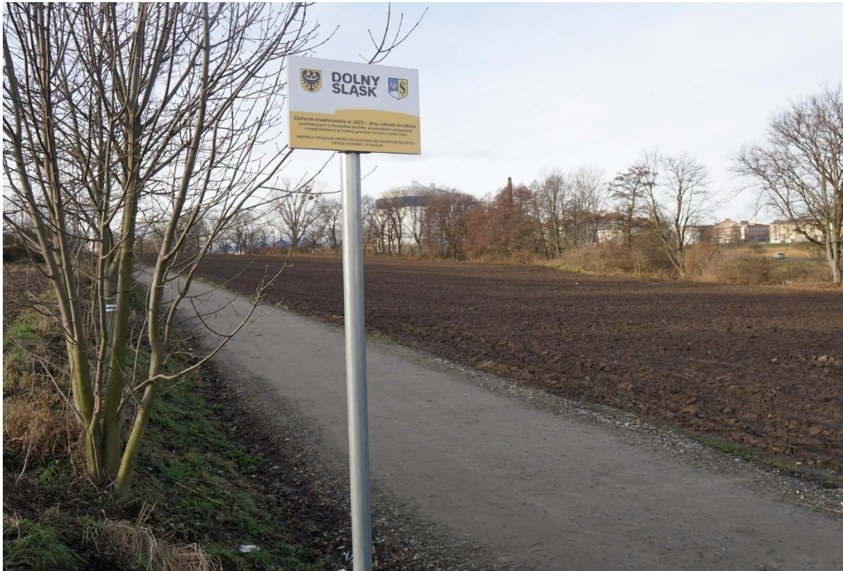
Zdjęcie 20. Fragment przebudowanej drogi Gęsiniec-Strzelin- droga dojazdowa do gruntów rolnych.
