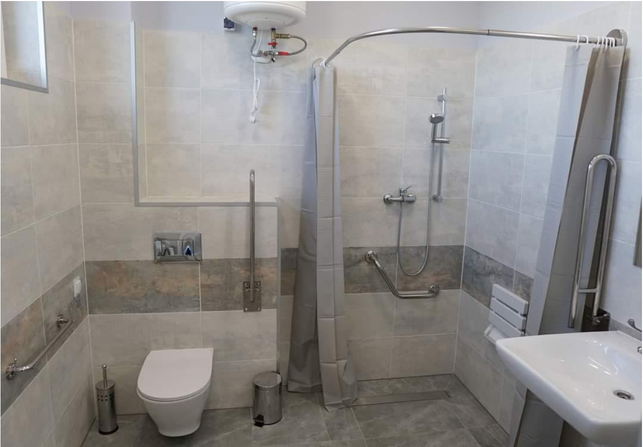
Zdjęcie 36. Szatnia na boisku sportowym w m. Chociwel - widok zaplecza sanitarnego.
