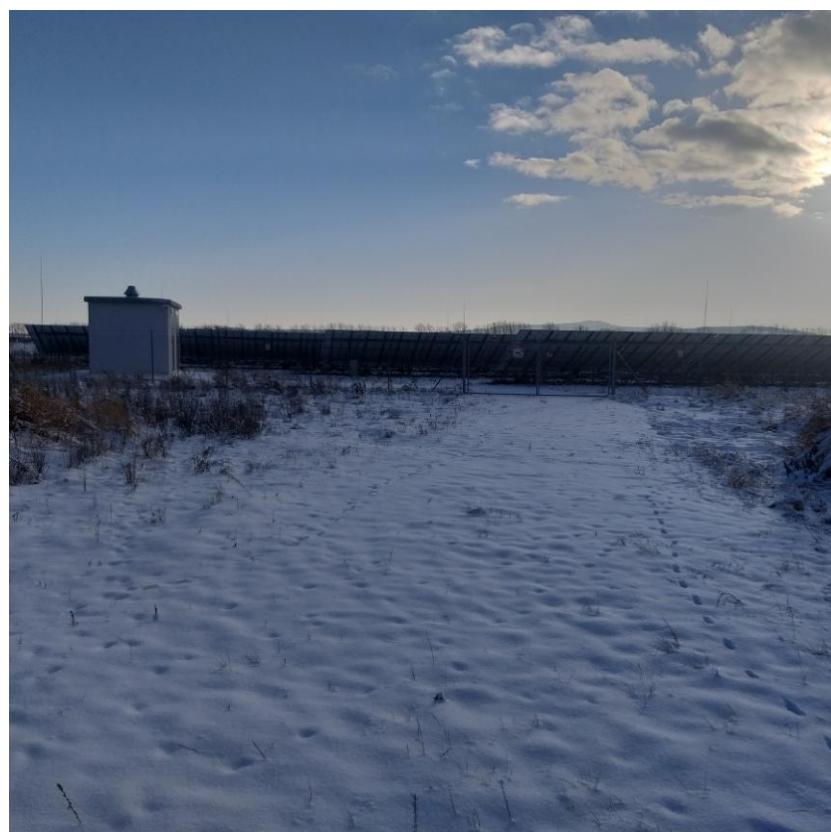
Ryc. 5. Widok z drogi dojazdowej (1KDD) w kierunku południowym – farma fotowoltaiczna
