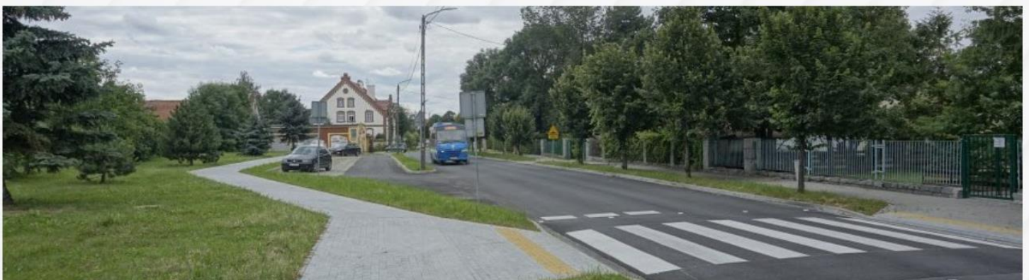
Ulica Brzegowa po remoncie
