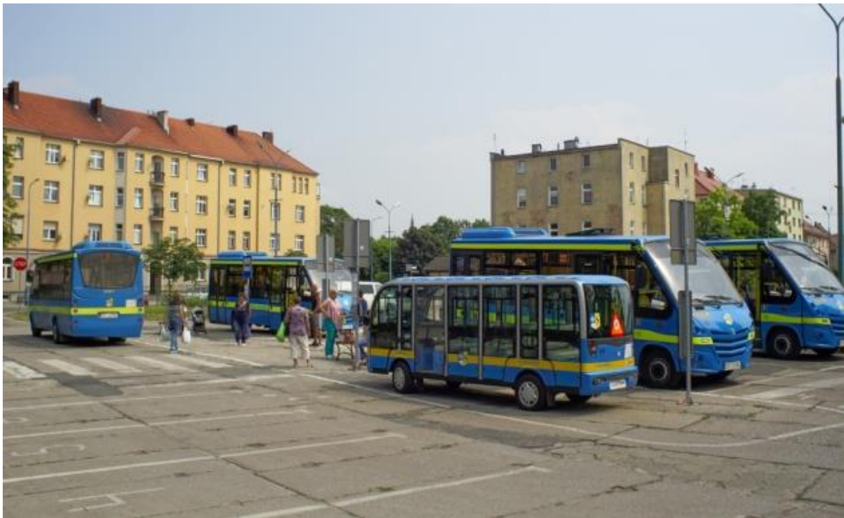
Zdjęcie 1. Węzeł przesiadkowy przed remontem.
