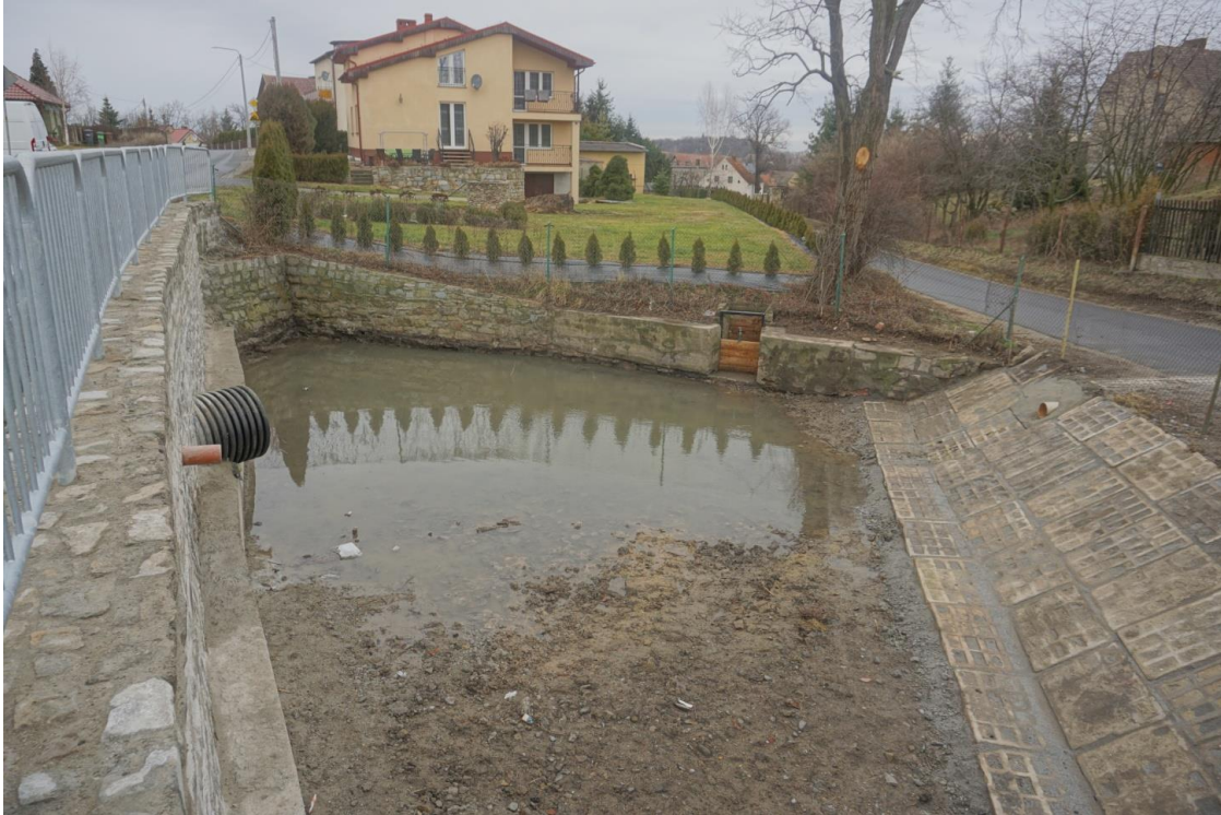
Zdjęcie 11. Przepust drogowy, ul. Akacyjowa Gęsiniec.
