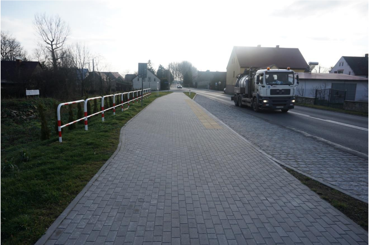
Zdjęcie 2. zatoka autobusowa w m. Strzegów.
