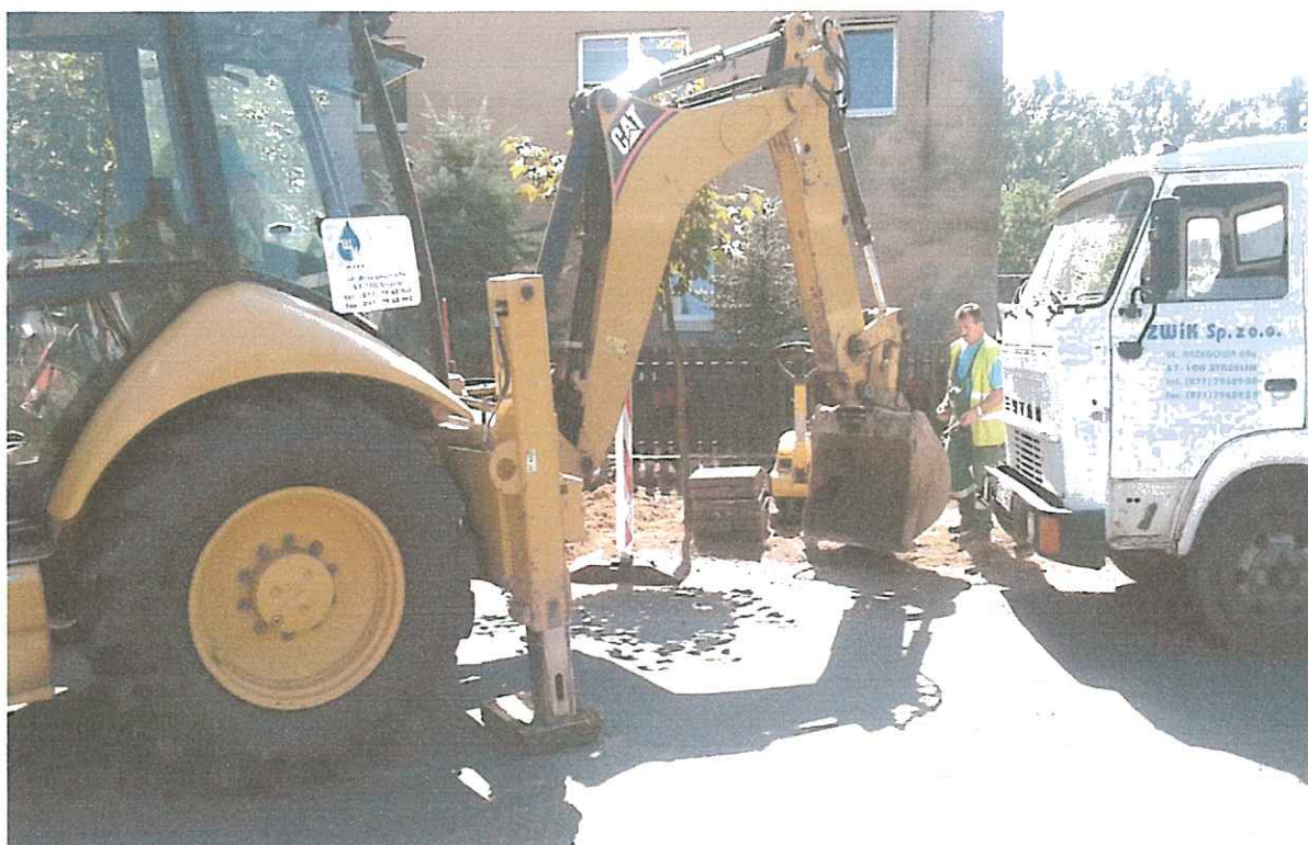
Prace budowlane prowadzone w miejscowości Górzec.
