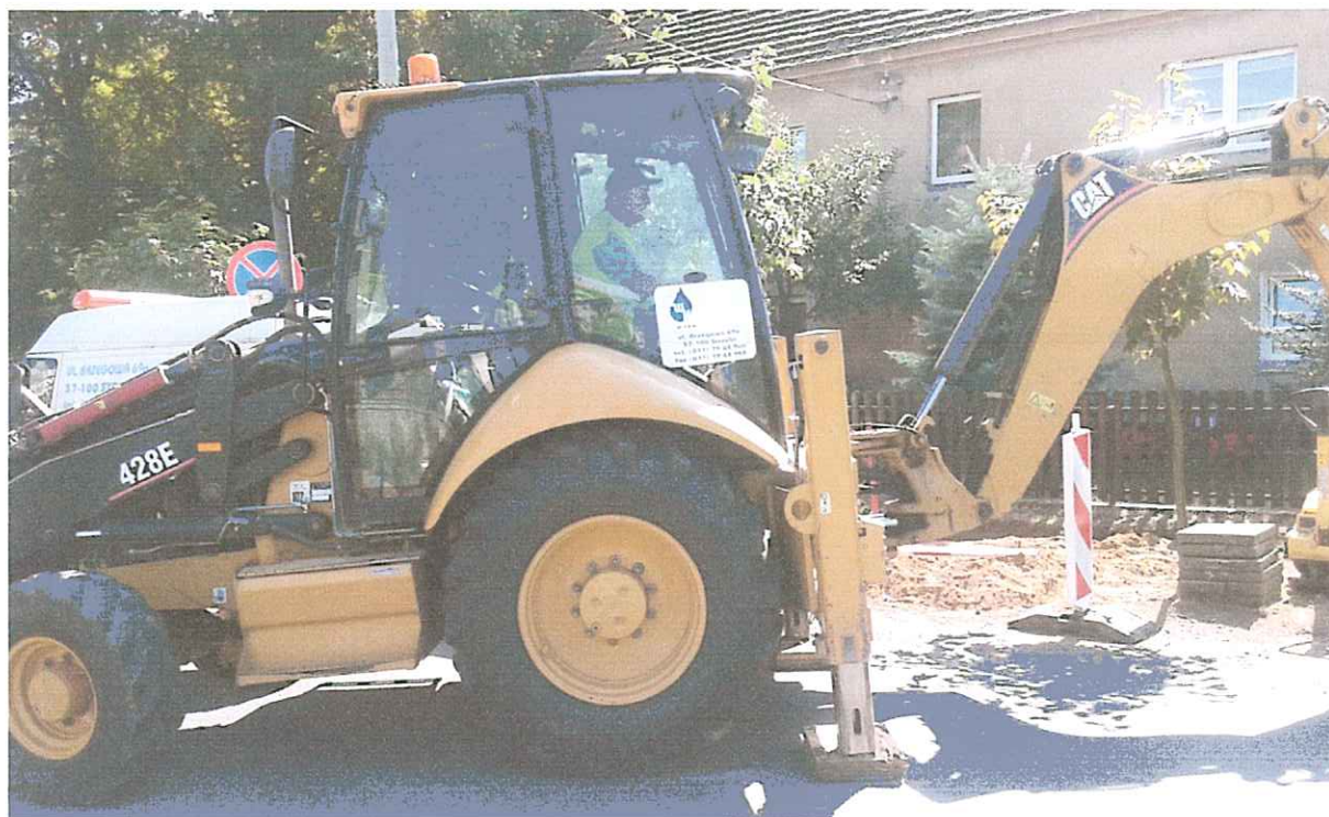
Prace budowlane prowadzone w miejscowości Górzec.
