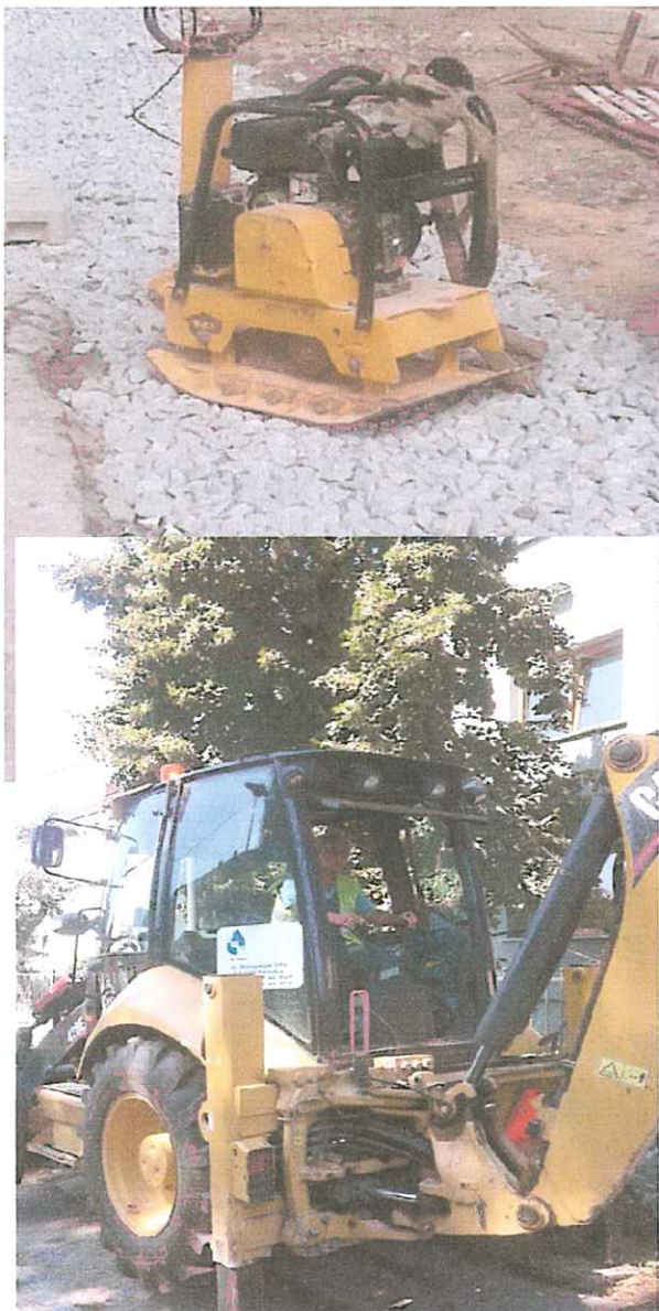
Prace budowlane prowadzone przy budowie wodociągu w ulicy Sikorskiego w Strzelinie..
