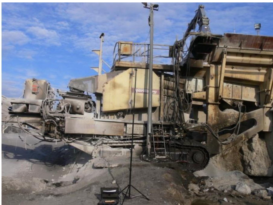
Fot. 20 Pomiar referencyjny kruszarki wstępnej Lokotrack LT125
