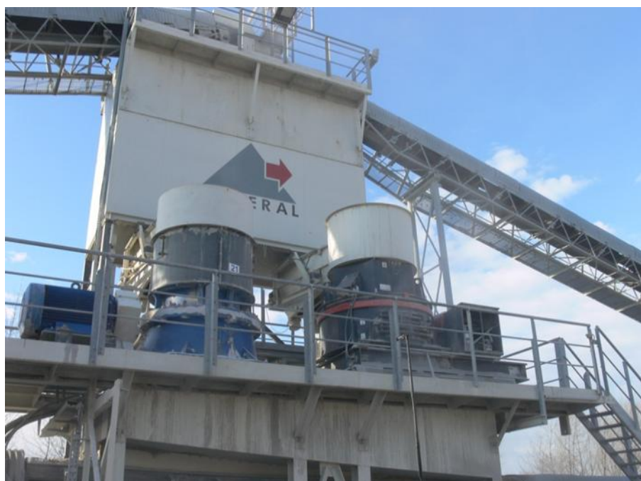
Fot. 23 Pomiar referencyjny kruszarki H488 i CV217
