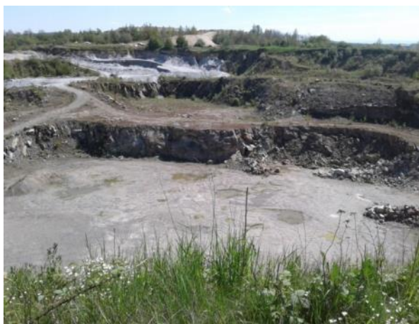
Fot. 1 Widok na wyrobisko w stanie aktualnym
