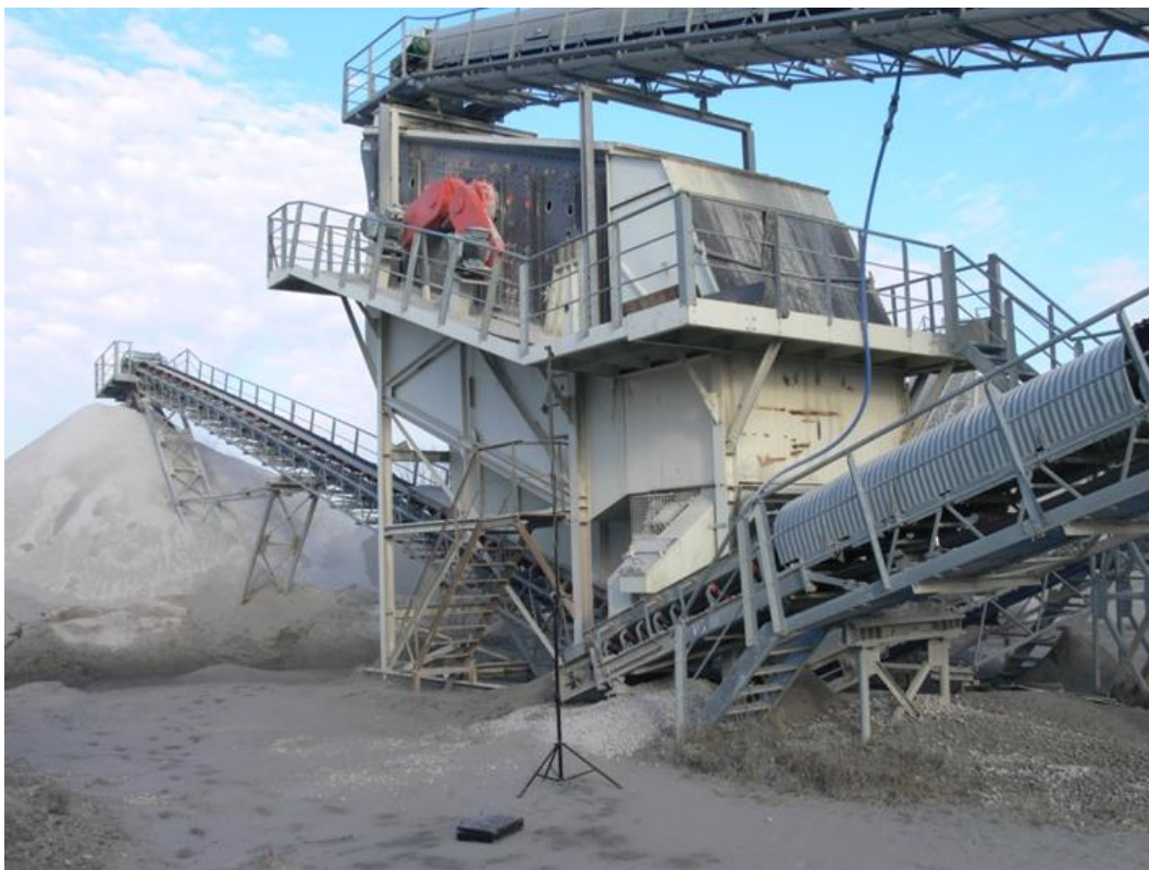
Fot. 8 Pomiar referencyjny przesiewacza nr 3 (CS 173T) (pkt 5)
